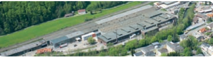
Werk Mürzzuschlag / Plant Mürzzuschlag
